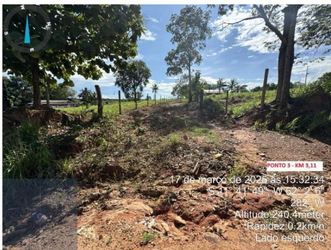
Imagem 01: erosão da sarjeta onde circula água pluvial, dificultando o acesso a propriedade rural
